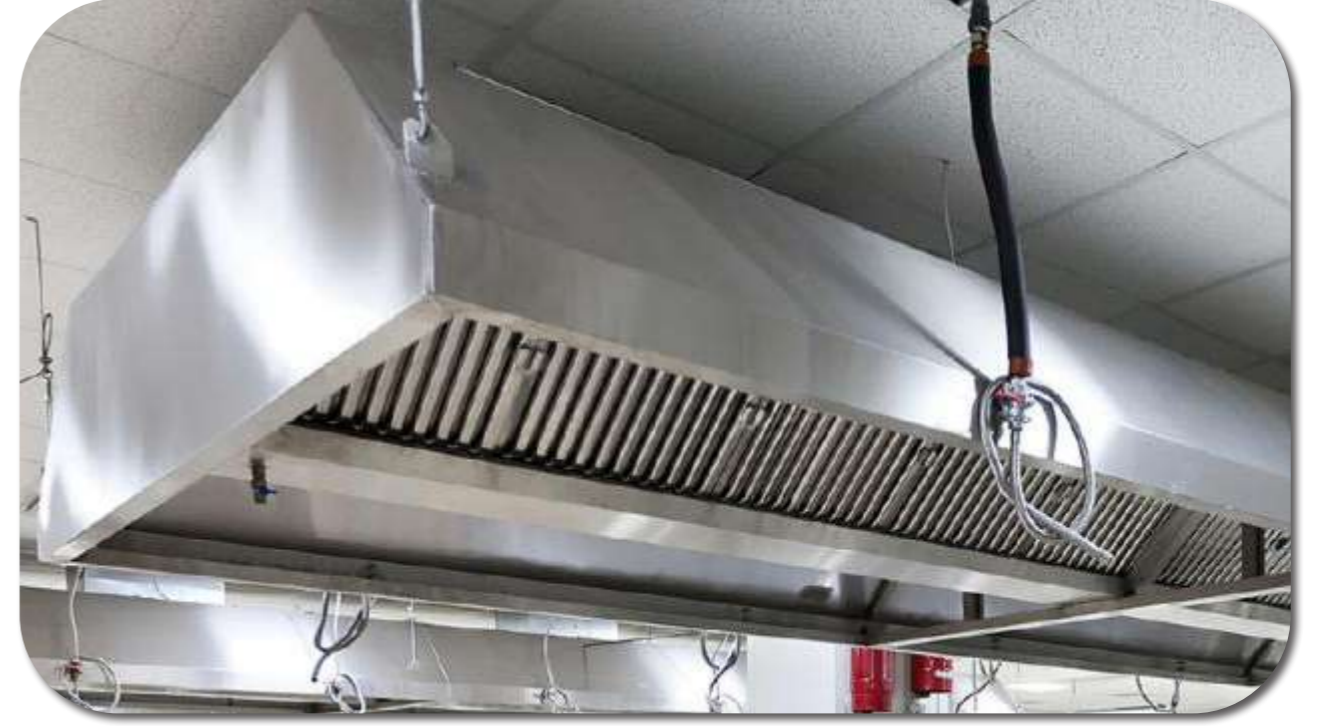
430 Paslanmaz Çelik / Stainless Steel Endüstriyel Davlumbazlarda Yağ Tutucu Görevini Yapar / Keeps Oil
